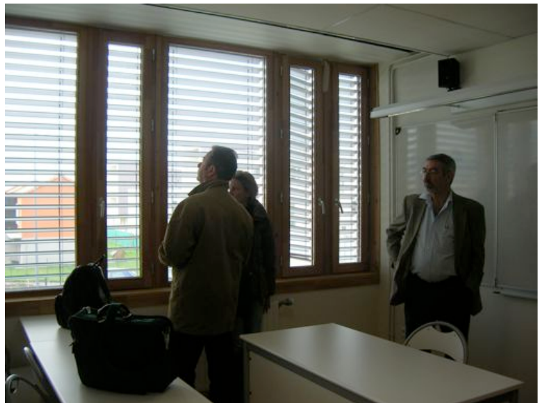
Les stores en aluminium électriques protégeant les salles du soleil.
