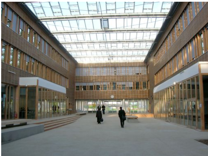
L'atrium du lycée. Les ouvertures automatisées sont apparentes dans la verrière
