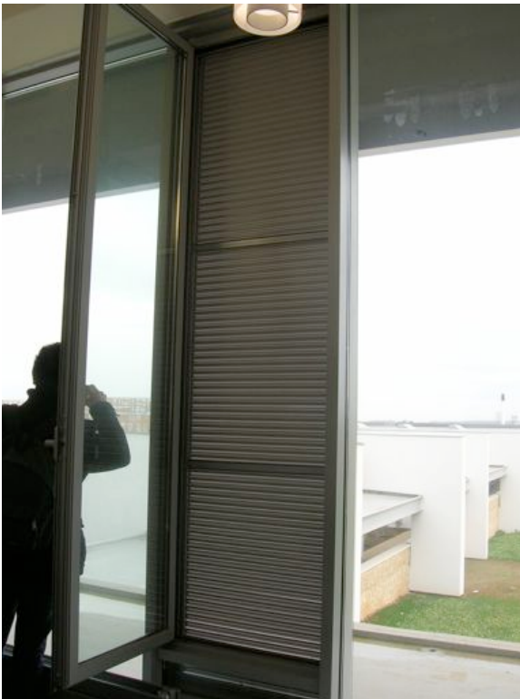
Les stores en aluminium électriques protégeant les salles du soleil.
